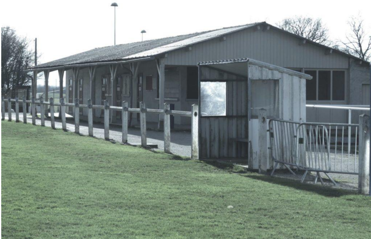
Vestiaires du stade © Eric Pellenard
